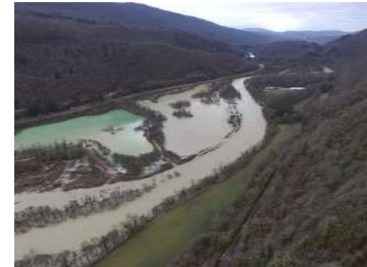
Crue 2021 qui montre le lit majeur et champ d'expansion de crue
