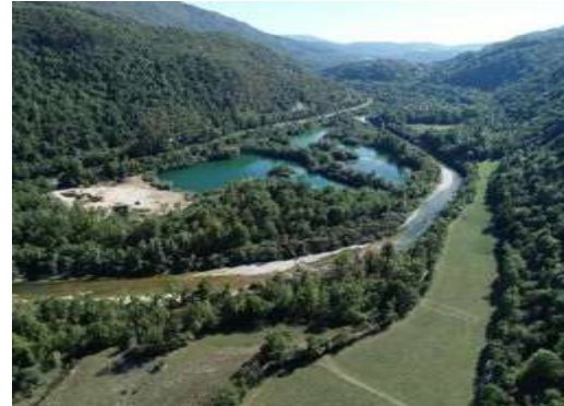
Avant les travaux, début 2021
